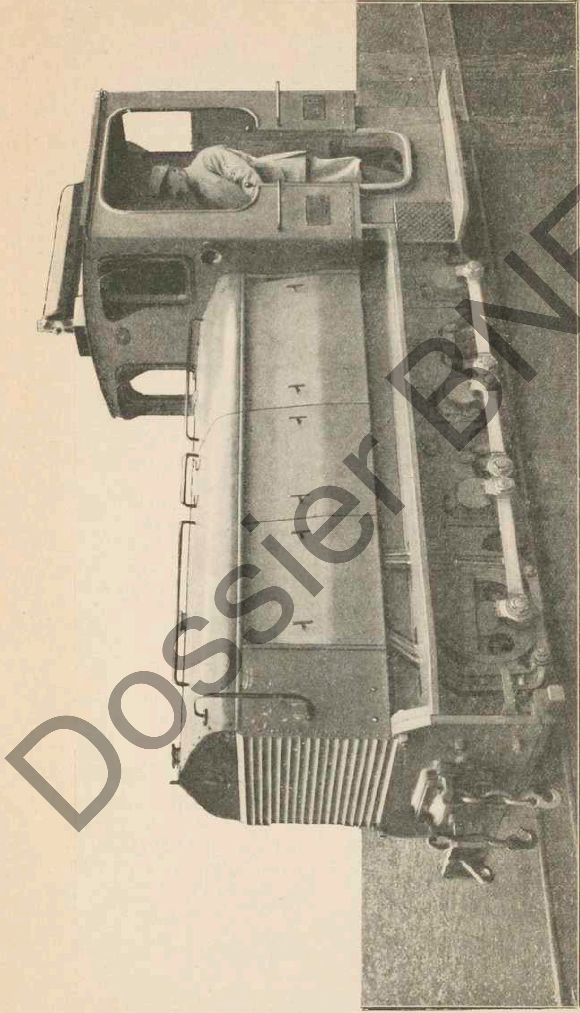
Locotracteur Schneider, Modèle 1916, pour voie de 60 cm. (Type L G).
